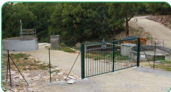
La rénovation de la station du quartier ouest a été complétée : mise en place de la double recirculation des eaux usées sur le clarificateur déjà existant, réhabilitation des lits de séchage des boues résiduelles...
